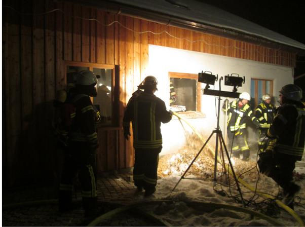
Ende Januar brannte es von einer Hackschnitzel-Heizung zurück in den Bunker-Raum. Der gesamte Vorrat wurde durch die kleine Wandöffnung ins Freie geschaufelt um an die versteckten Glutnester an der Förderschnecke zu gelangen
